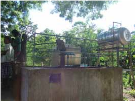
写真 KC1 (民家)
