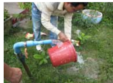
電気ポンプ井戸
