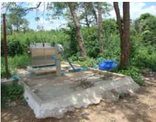
写真 KC8 (民家)
