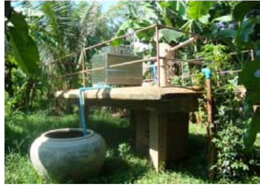
写真 KC2 (民家)
